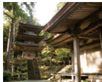
明通寺・本堂と三重塔
